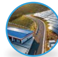
Autobahn-PV mit integriertem BESS
