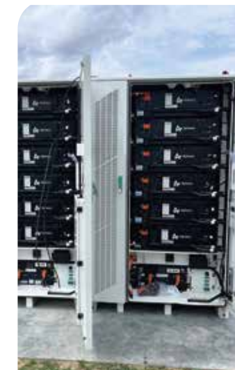
Installationsvorbereitung (vorverlegte Kabel)
